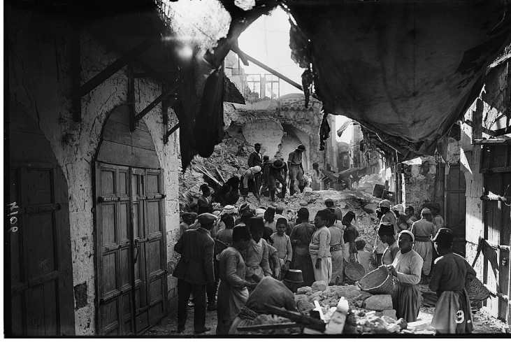
شكل (5): انهيارات في مباني في البلدة القديمة - مدينة نابلس، زلزال 1927.
