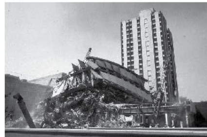
شكل (1): انهيار المباني بسبب ظهور ظاهرة الرنين - زلزال المكسيك 1985
