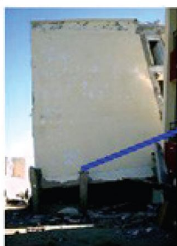
المغرب 2004 : اصطدام المبنيين بسبب عدم وجود عرض كاف للفاصل الزلزالي
