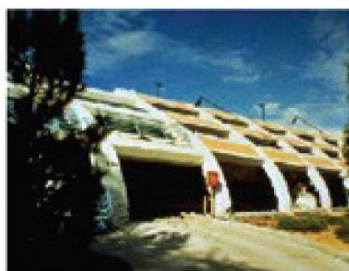
انهيار بسبب وجود رخاوة في الطابق الأرضي
